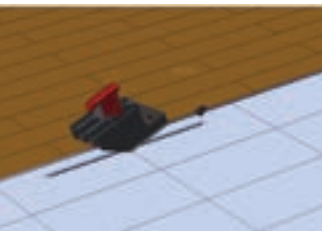
Koruyucu kapağı çıkarak yükseklik ayar parçasını kotunu terazi ile her noktadan ayarlayınız. / Remove the protective styropor and adjust the level the gradual parts with scale from each point.
