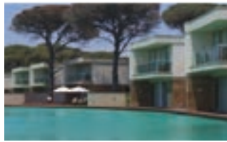
SEMBOL İNŞAAT - RİXOS BELEK
