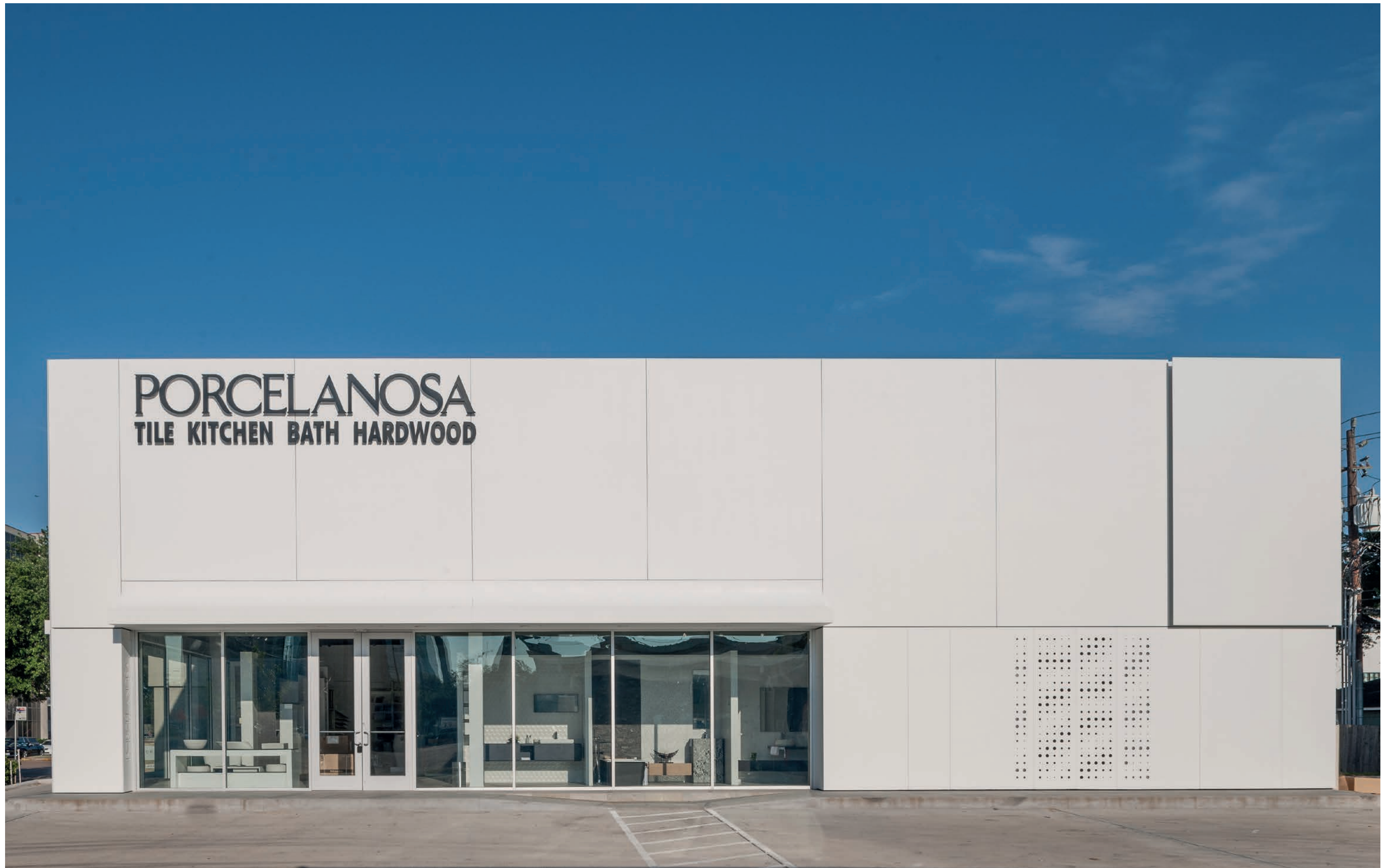
Ventilated façade & KRICN®
